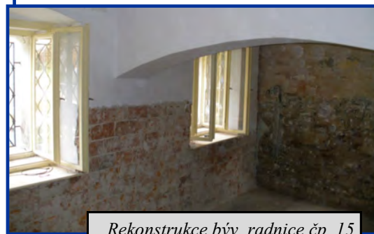
Rekonstrukce býv. radnice č.p. 15
